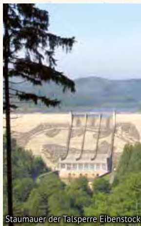
Staumauer der Talsperre Eibenstock
