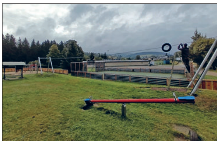
Mitarbeiter der Schlosserei spannt das Seil der Laufkatze
