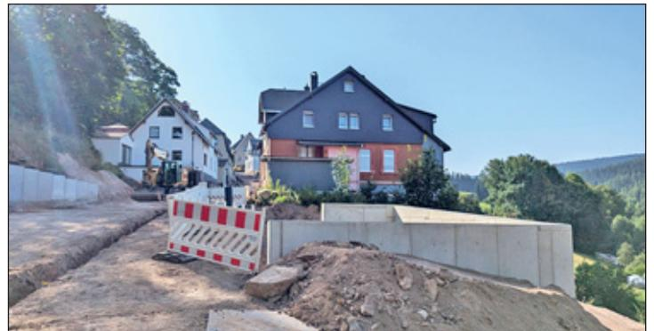
Der Wendebereich ist mittlerweile durch die Stützelemente so stabilisiert worden, sodass nunmehr hier auch die Straßenaufbauarbeiten beginnen können.
