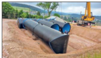
Von der quer verbauten Schieberkammer mit Technik und den abgehenden drei Riesenrohren mit drei Metern Durchmessern, die jeweils 100 m<sup>3</sup> Trinkwasser speichern können, wird nach Fertigstellung und Geländeanpassung nichts mehr zu sehen sein. Nur die bereits errichtete Mauer wird auf das Bauwerk hinweisen. Der alte Hochbehälter im Bechsteingrund soll nach Außerbetriebnahme abgerissen werden.
