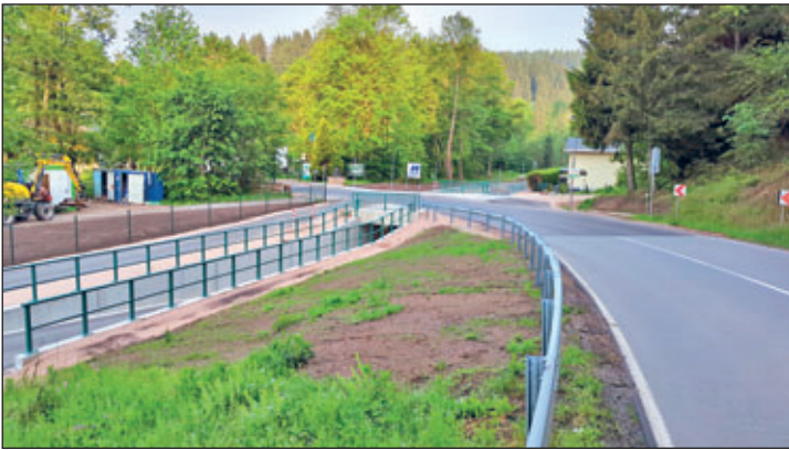
Die Leitplanken sowie Absperrgeländer sorgen für die nötige Sicherheit auf der Bundesstraße.
