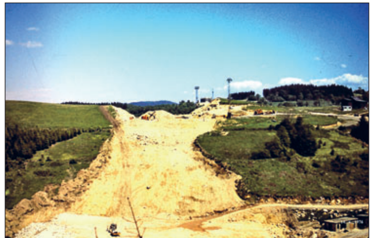
Bau des Rähmerbachdammes (heute darauf die B 283)
